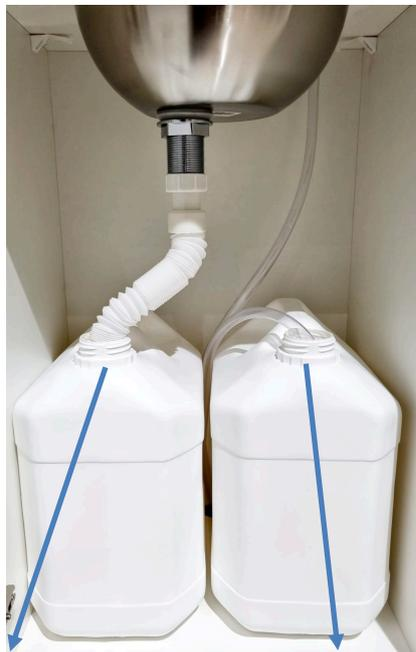
Posee dos estanques interiores de 20 lt y por medio de una bomba de pie activa el funcionamiento expulsando el agua por la grifería superior, desechandola hacia el estanque de agua en el interior.
